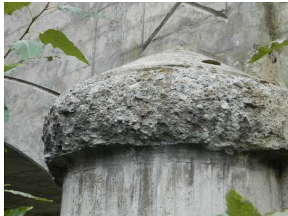
SI-7~I~W~Deterioration_on_Top_of_Pilaster~2011-10-04_.jpg
